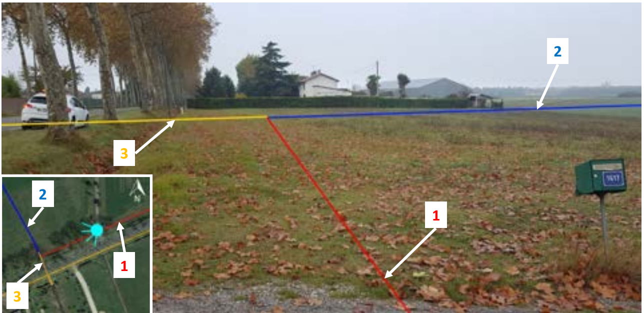
1 : Branchement DN80 EMISSION EX SINERG A MONTECH projeté - 2 : Branchement DN80 SINERG EMISSION A MONTECH existant - 3 : Branchement DN80 DEPART EX SINERG A MONTECH à mettre à l'arrêt définitif d'exploitation
